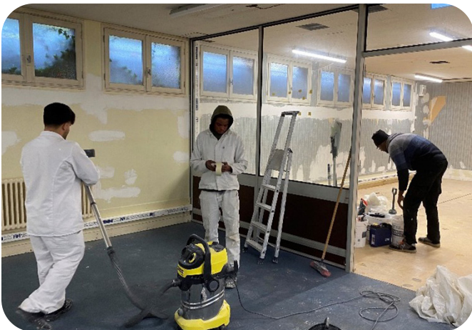
► travaux Locaux Avenue de Vendôme avant emménagement
